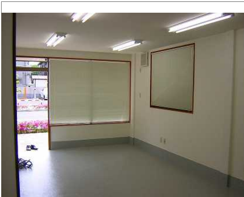
・改修後内部2
